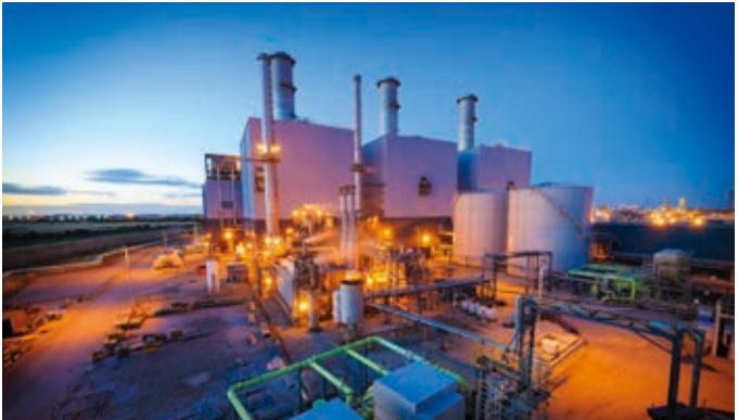
ソルトエンドGTCC発電所
