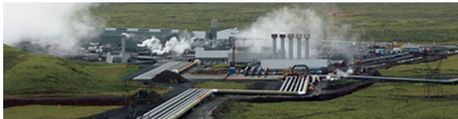
納入先 プラント名(国名) レイキャビク・エナジー社 ヘッドリスハイディ地熱発電所 (アイスランド) 出力 25万kW 運転開始年 2006年-201 年
