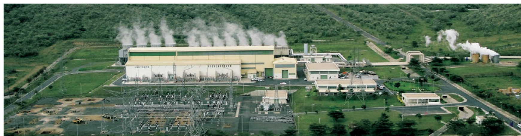
納入先 プラント名(国名) ケニア電力公社 オルカリアII発電所 (ケニア) 出力 10万5,000kW 運転開始年 2003年 / 2010年
