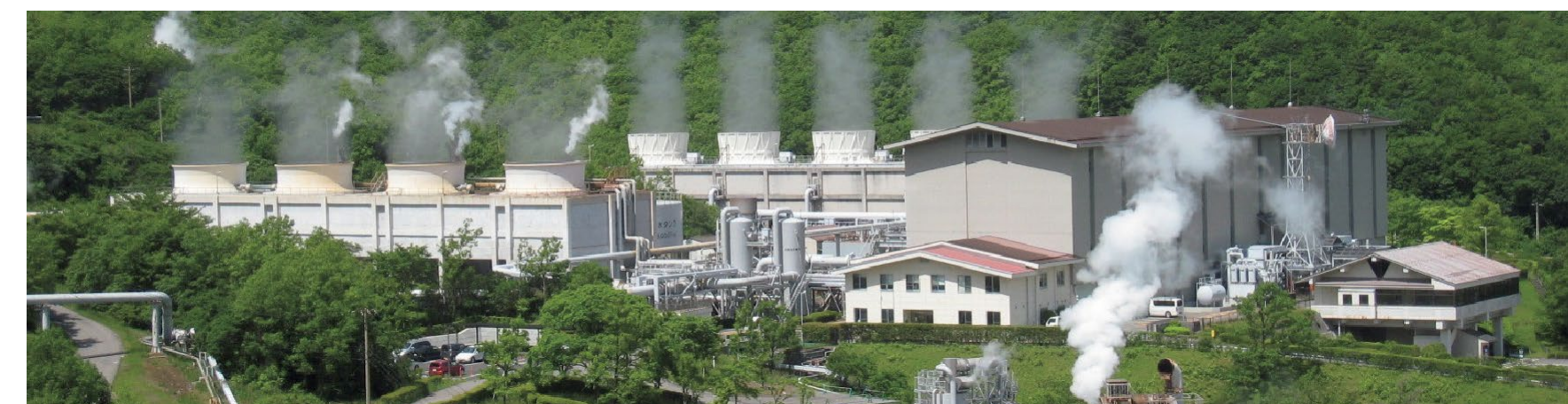
納入先 プラント名(国名) 九州電力株式会社 八丁原発電所1、2号機 (日本) 出力 11万kW 運転開始年 1977年 / 1990年
