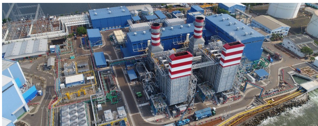
納入先 プラント名(国名) 出力 運転開始年 PT. PLN社 タンジュンプリオク発電所(インドネシア) 88万kW 2019年
