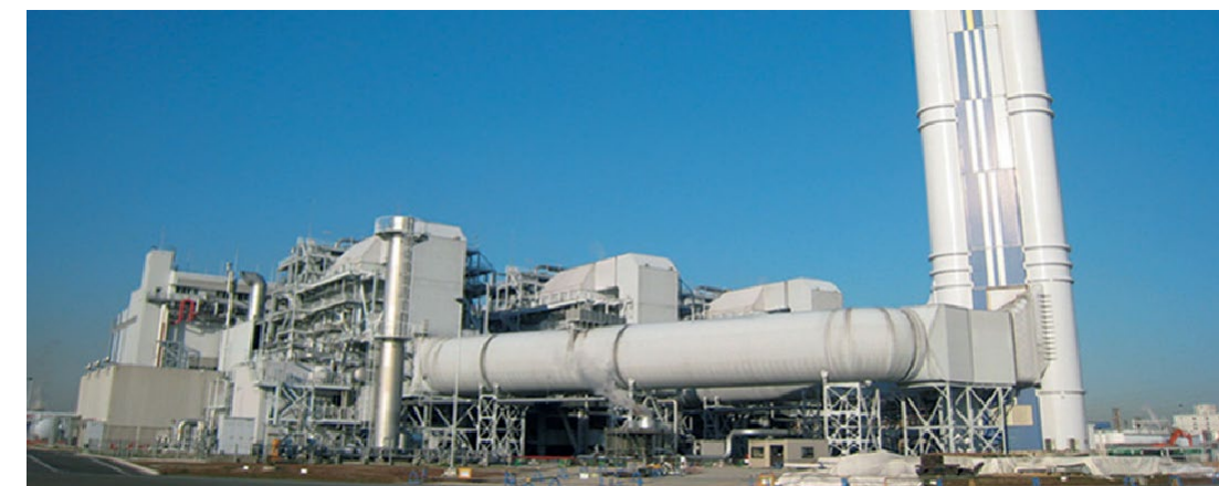
納入先 プラント名(国名) 出力 運転開始年 株式会社JERA 川崎火力発電所1、2号系列(日本) 342万kW 2009年 / 2016年
