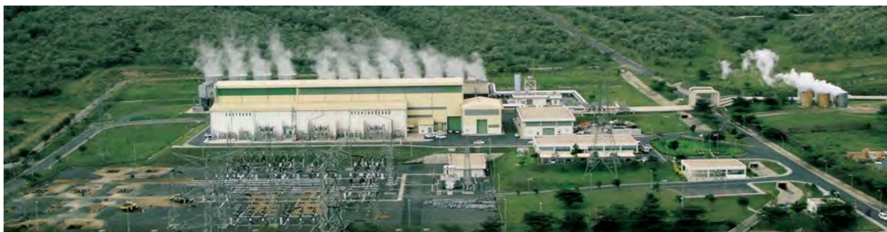
納入先 ケニア電力公社 プラント名(国名) オルカリアII発電所 (ケニア) 出力 10万5,000kW 運転開始年 2003年 / 2010年
