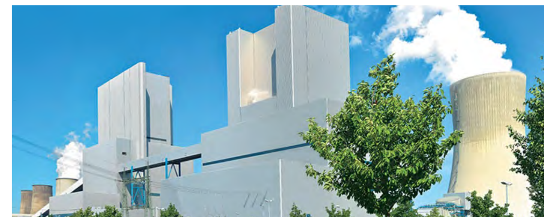
納入先 バッテンフォール社 プラント名(国名) ボックスベルク火力発電所 (ドイツ) 出力 67万kW 燃料 褐炭 運転開始年 2012年
