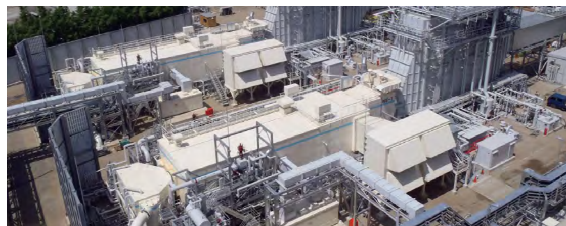
納入先 東北電力株式会社 プラント名(国名) 新潟火力発電所5号系列 (日本) 出力 10万9,000kW 運転開始年 2011年
