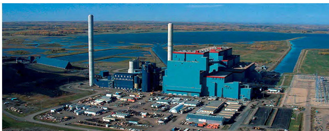
納入先 キャピタルパワー社 / トランスアルタ社 プラント名(国名) ジェネシー火力発電所3号機 (カナダ) 出力 49万5,000kW 燃料 瀝青炭 運転開始年 2005年
