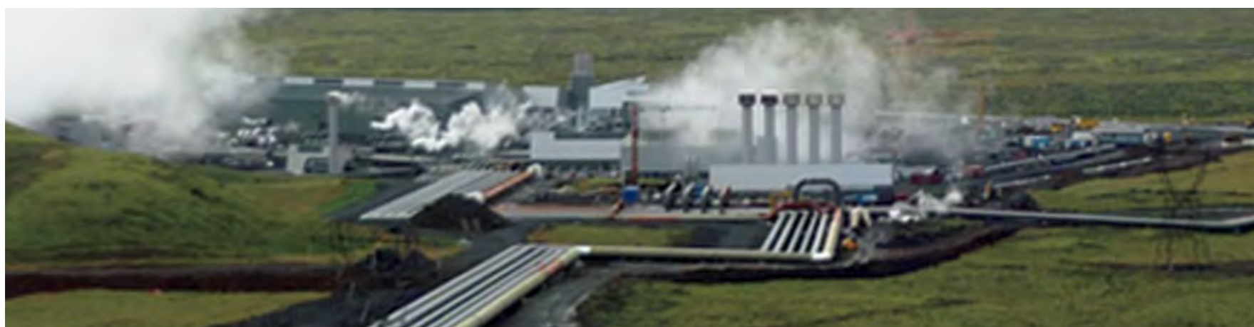
納入先 レイキャビク・エナジー社 プラント名(国名) ヘッドリスハイディ地熱発電所 (アイスランド) 出力 25万kW 運転開始年 2006年-2011年
