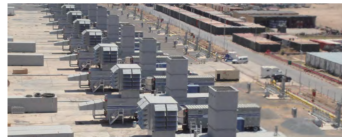
納入先 Sonelgaz社 プラント名(国名) アルジェリア 出力 1,350MW (FT8MP×54台) 運転開始年 2011年 / 2014年 / 2015年 / 2017年
