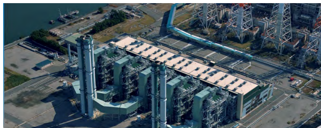
納入先 関西電力株式会社 プラント名(国名) 堺港発電所1~5号機 (日本) 出力 200万kW 運転開始年 2009年 / 2010年
