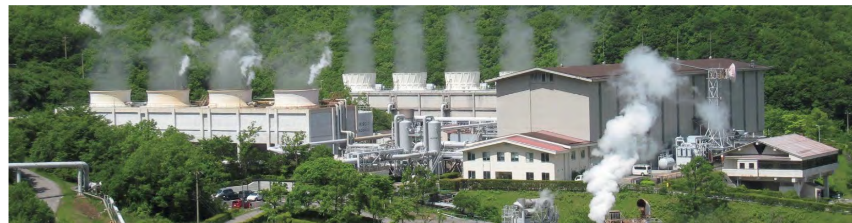
納入先 九州電力株式会社 プラント名(国名) 八丁原発電所1、2号機 (日本) 出力 11万kW 運転開始年 1977年 / 1990年
