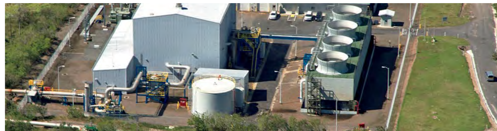
納入先 コスタリカ電力公社 プラント名(国名) ミラバジェスIII発電所 (コスタリカ) 出力 2万7,000kW 運転開始年 2000年
