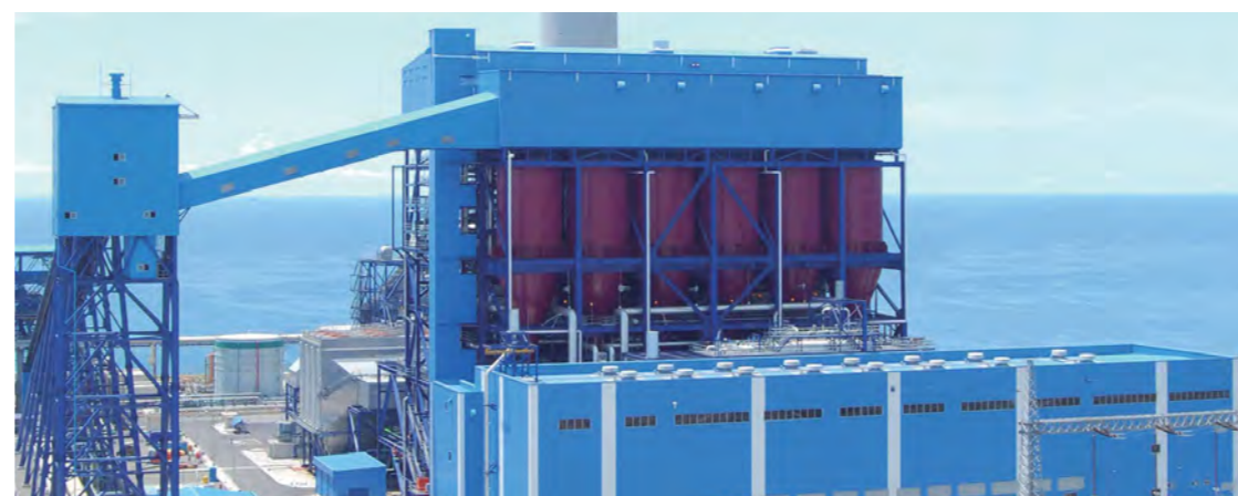
納入先 パイトンエネルギー プラント名(国名) パイトンIII発電所 (インドネシア) 出力 86万6,000kW 燃料 亜瀝青炭 運転開始年 2012年
