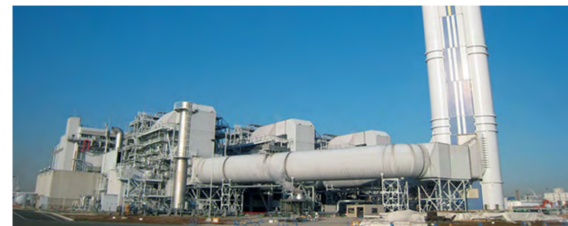
納入先 株式会社JERA プラント名(国名) 川崎火力発電所1、2号系列 (日本) 出力 342万kW 運転開始年 2009年 / 2016年
