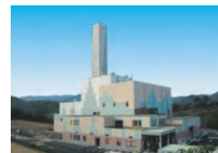
都市ごみ焼却施設
