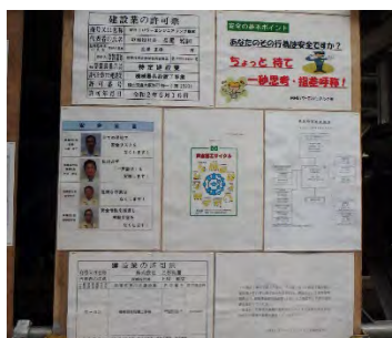
冷却塔工事現場
