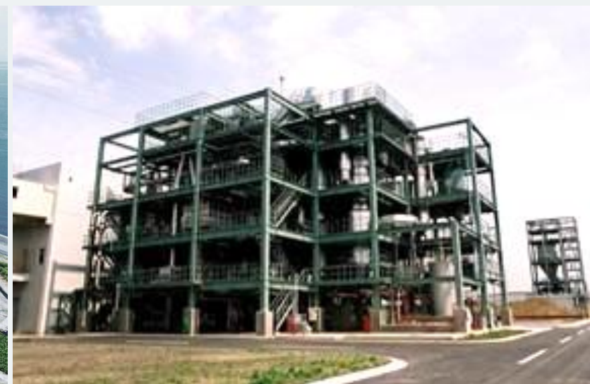
汚泥焼却施設
