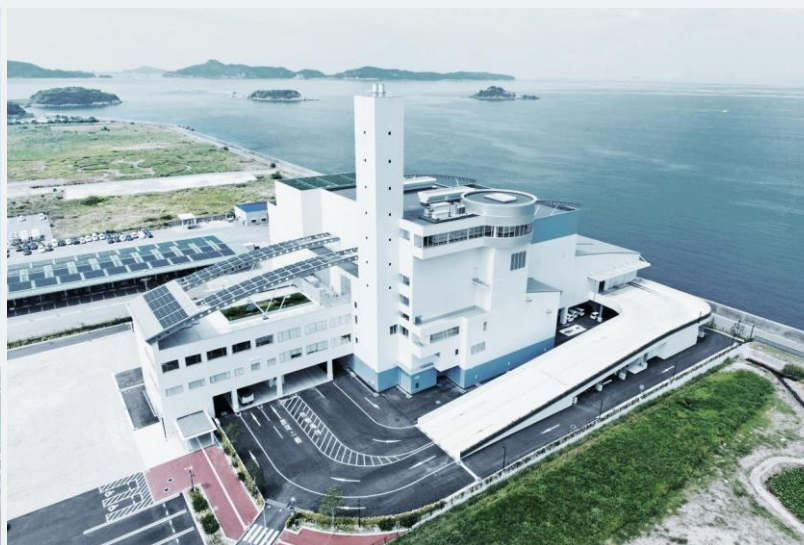
都市ごみ焼却施設
