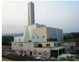
都市ごみ焼却施設 Urban garbage
