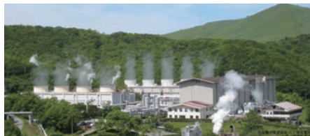
地熱発電プラント Geothermal Power Plant
