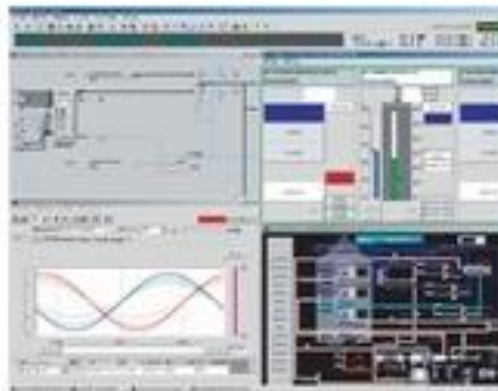
運転監視システム
