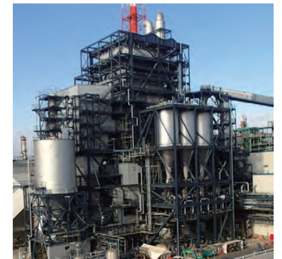
石油コークス/VR焚ボイラ(530t/h) PC/VR burning boiler(530t/h)
