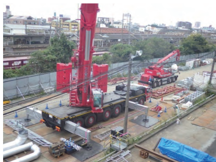
360 t 重機設置（ドラム、タービン取込用） 360ton heavy equipment (Installation for drum, turbine)
