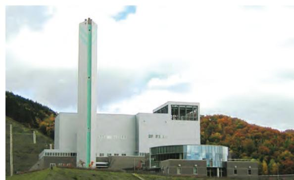
55t/24h×3炉 発電付流動床式焼却施設
