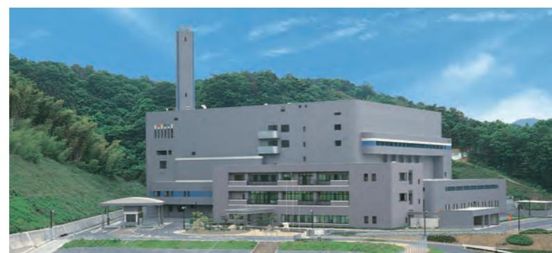
110t/24h×3炉 発電付流動床式焼却施設
