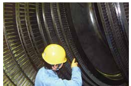
蒸気タービンロータ目視
