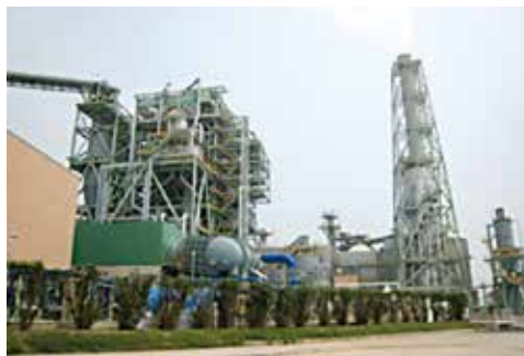
ボイラプラント QC・SV 業務
