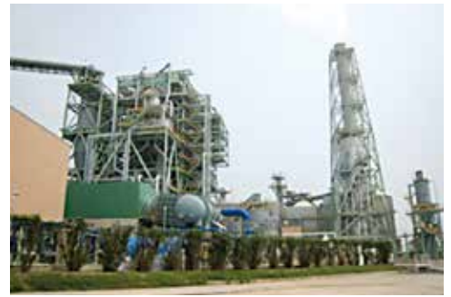
ボイラプラント QC・SV 業務
