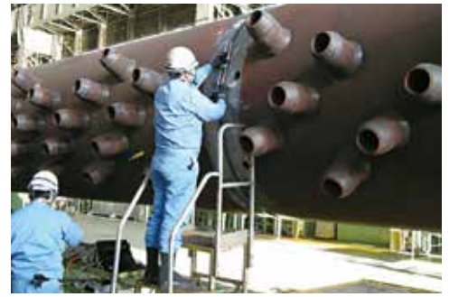
円周継手溶接部 TOFD
