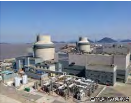
原子力発電所
