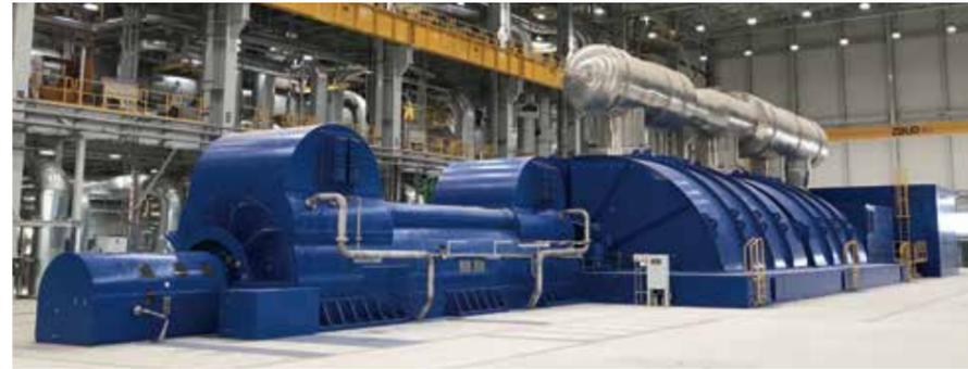
火力用蒸気タービン・発電機
