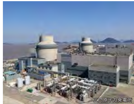
原子力発電所
