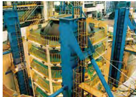
圧力容器水圧試験用ピット
