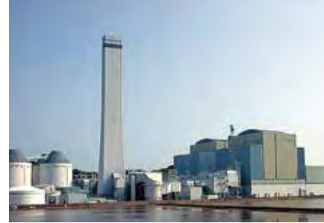
ボイラー(3,000トン/h 石炭焚貫流ボイラー 105万kW)
