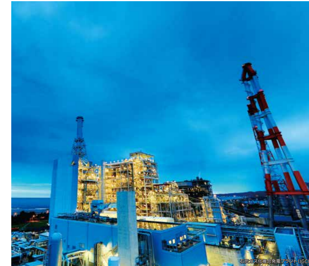
石炭ガス化複合発電プラント (IGCC)
