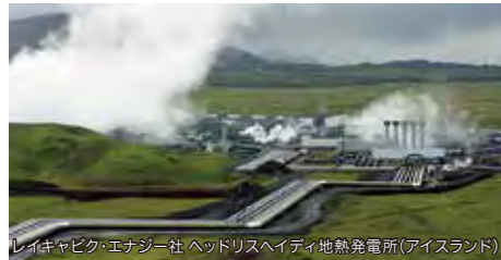
地熱発電プラント
