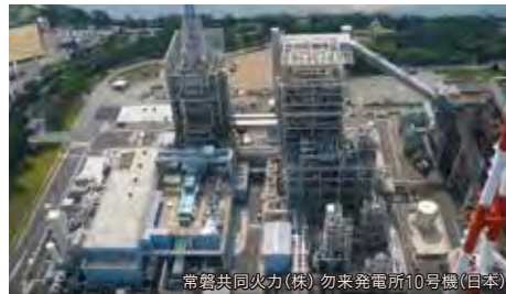
石炭ガス化炉、排熱回収ボイラー
