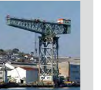
ジャイアント・カンチレバークレーン(非公開施設)
