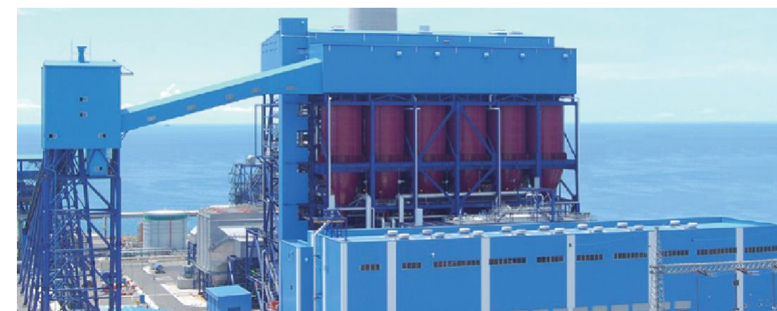
納入先 プラント名(国名) パイトンエネルギー パイトンIII発電所 (インドネシア) 出力 86.6万kW 燃料 亜瀝青炭 運転開始年 2012年
