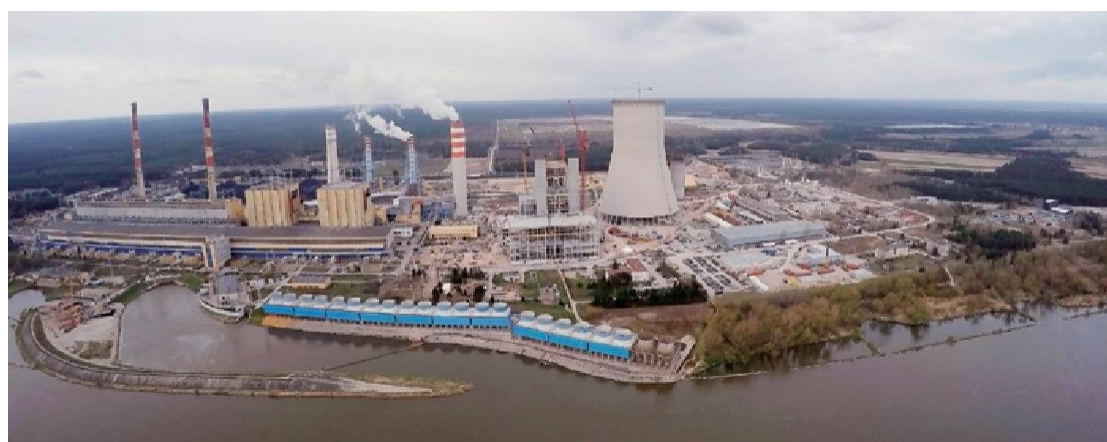
納入先 プラント名(国名) エネア・ ヴィトバルザニエ社 コゼニツェ火力発電所11号機 (ポーランド) 出力 107.5万kW 燃料 瀝青炭 / 亜瀝青炭 運転開始年 2017年
