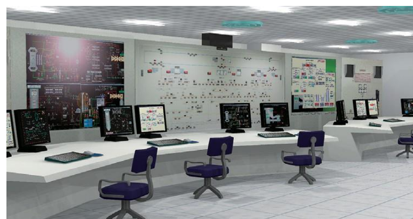
➤ 制御システム
