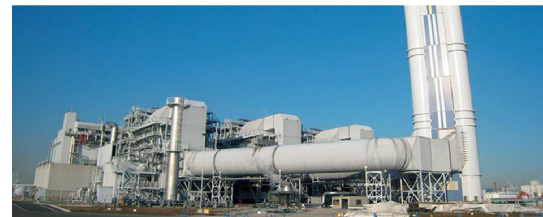
納入先 プラント名(国名) 株式会社JERA 川崎火力発電所1、2号系列(日本) 出力 342万kW 運転開始年 2009年 / 2016年
