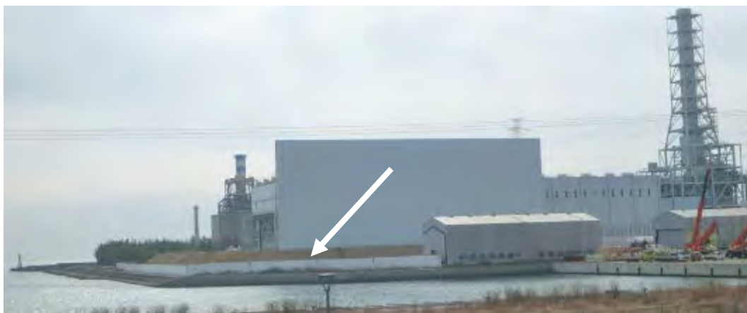
写真 4-2 仮設防音壁の設置状況 (2020 年 3 月 13 日撮影)
