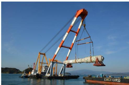
図7 ガス化炉水切り状況
