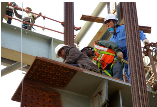
図3 最前線の建設現場における技術指導
