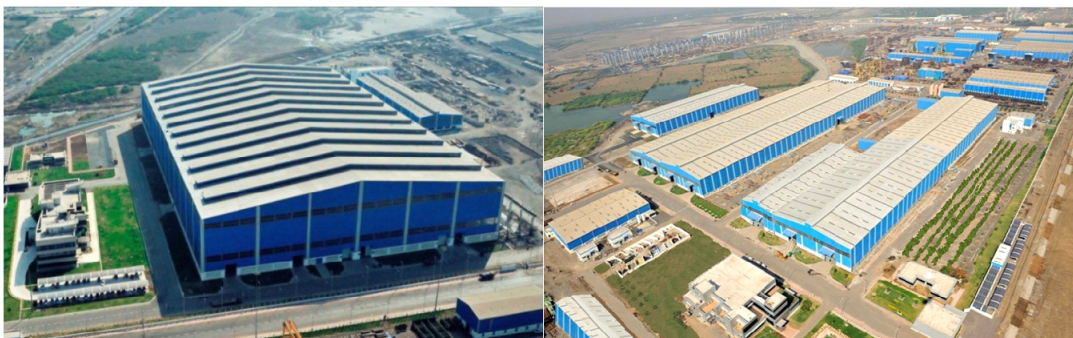
図1 インド合弁会社ハジラ工場全景 (左:タービン・発電機工場, 右:ボイラ・ミル工場)
