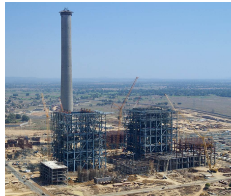
図5 インドの発電設備建設現場
