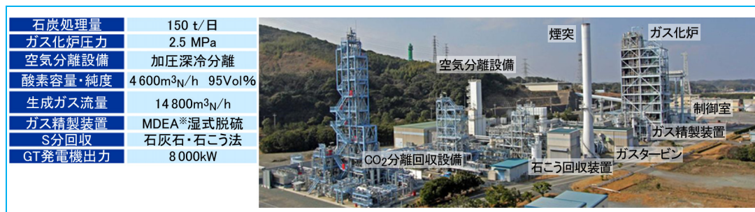
図7 革新的 CO 2 回収型石炭ガス化技術開発 (Coal Energy Application for Gas, Liquid and Electricity: EAGLE-STEP3)パイロットプラント概要
