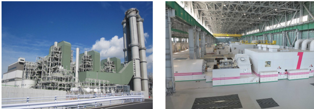
図9 関西電力(株)姫路第二発電所 M501J 形ガスタービンコンバインドサイクルプラント全景
