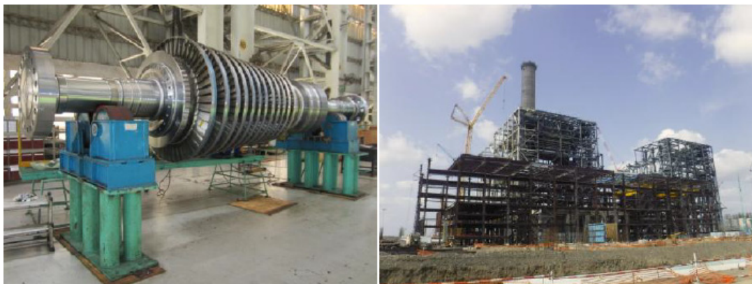
図3 NTPC Khargone(製作・建設状況)
