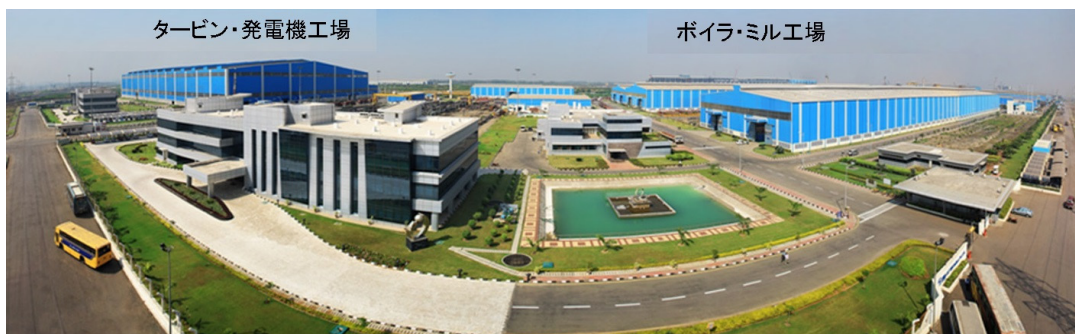
図1 LMB/LMTG ハジラ工場全景
