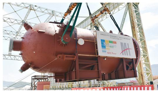
図6 ガス化炉圧力容器
