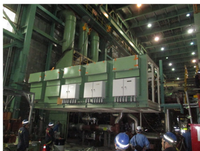
図4 新製燃料ガスユニット据付
