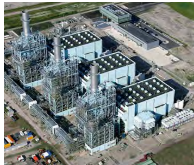
Vattenfall's Magnum GTCC power plant
