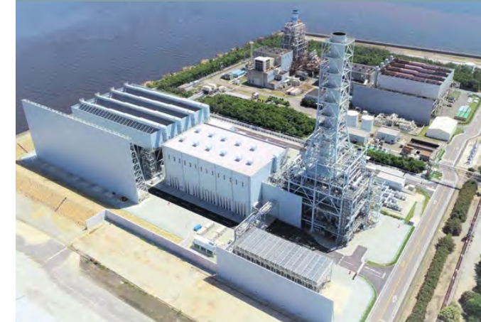
写真手前:第二T地点 写真奥:T地点
