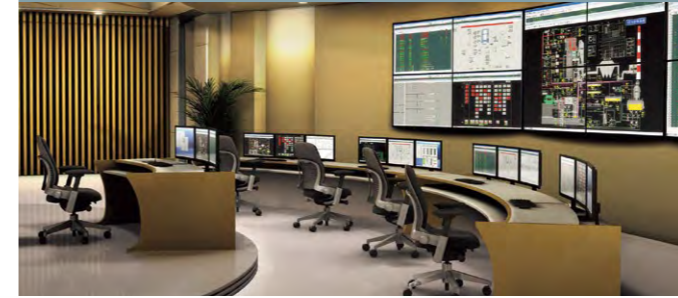
プラント制御システム
